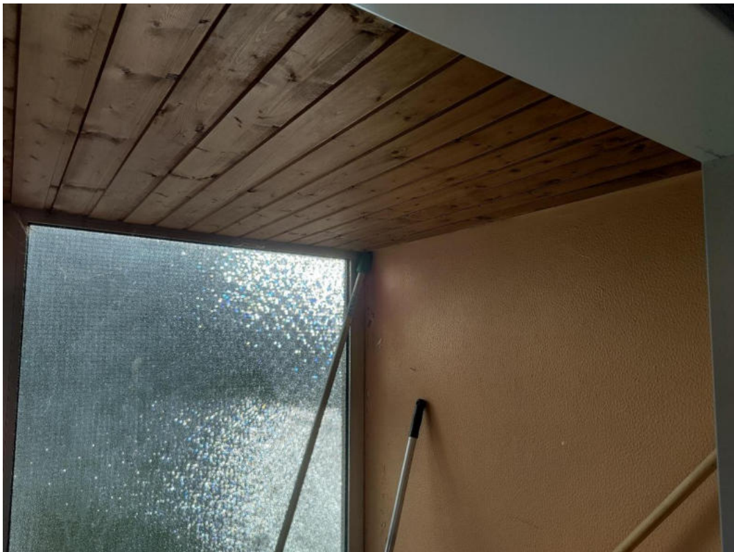
Bild 8 : Gebäude A2- PCP- hatige Holzbekleidung im Treppenhaus PCP. 850 mg/kg gemäß frühere Schadstoffuntersuchungsberichte(Die Wessling GmbH am 08.05.2013)
