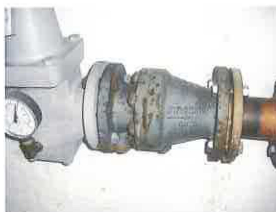
Foto 7: Schule, KG, K2, Flanschdichtungen (MP-57)
