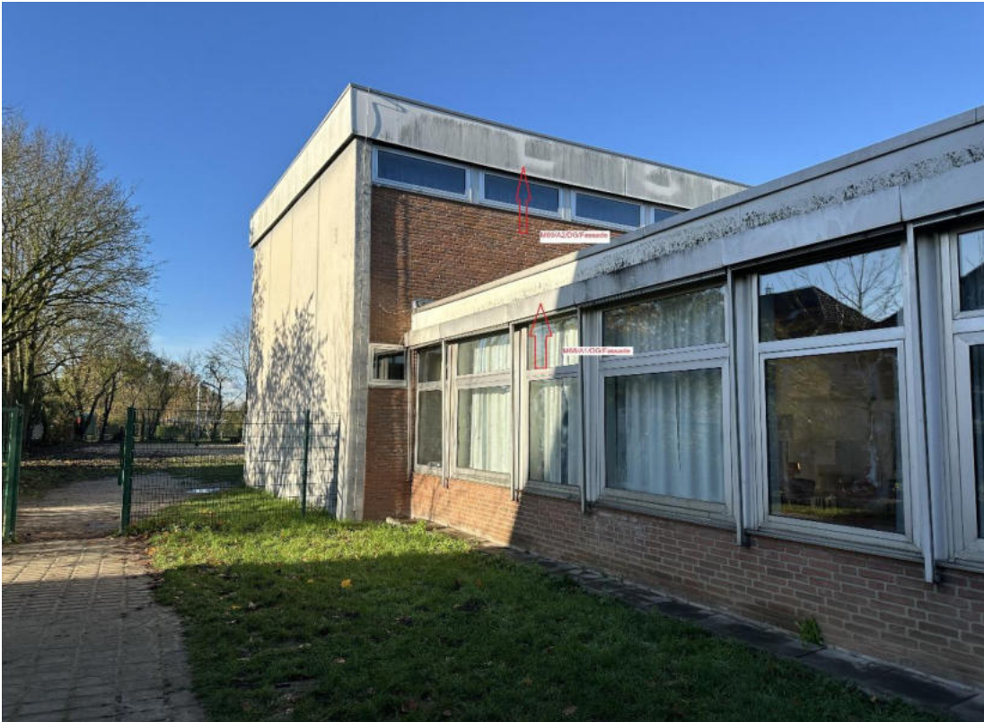
Bild 9 : Gebäude A2 – Attika: Nordliche Ansicht-Die Schindeln im Außenbereich oberhalb der Fenster im Erdgeschoss an der Süd-, Nord-, West- und Ostseite des Gebäudes sind asbesthaltig. Probe: M69/A2/DG/Fassade Hinweis: Die Attika-Schindeln im 1. Obergeschoss waren nicht asbesthaltig. Proben: M67/A2/DG/Dach und M68/A2/DG/Fassade
