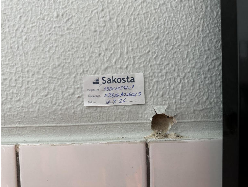
Bild 7 : Gebäude A2 – Fugenmasse zwischen Mauerwand und Fliesenpiegel im Erdgeschoss und 1. Obergeschoss sind asbesthaltig . Proben: MP80, M82, M83, M84, M85.
