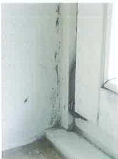
Foto 21: Schule, KG, K1, Fensterfugen, Schimmelpilzbefall (MP-63)
