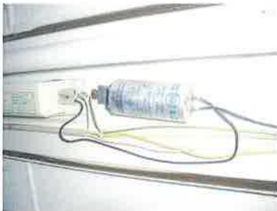
Foto 18: Schule, EG, Lampenkondensatoren (MP-40)
