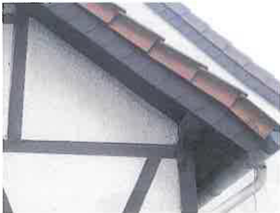
Foto 1: Hexenhaus, außen, Attika, AZ- Schindeln (MP-12)
